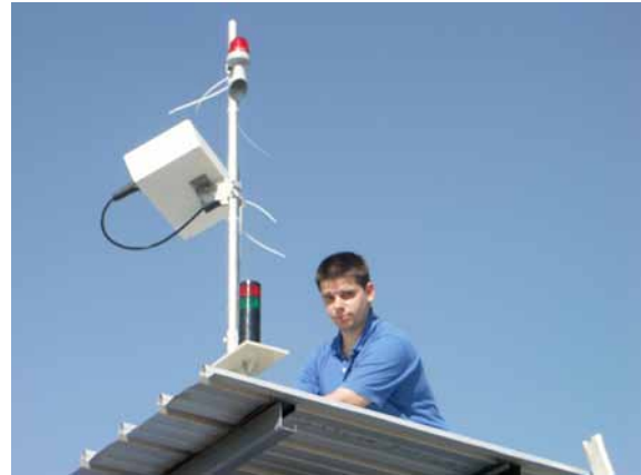
Abbildung 6: Sven Ketzer von proaqua installierte die Anlage und blieb für eine Einweisung der Dorfbewohner noch einige Wochen vor Ort. Neben ihm auf dem Dach des Containers der Transceiver, der via Satellit die Verbindung ins Internet möglich macht. Auf diese Weise wird die Anlage fernwartbar.
